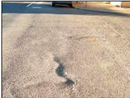
Gambar 2.13 Kerusakan Sungkur atau Jembul ( Shoving )
