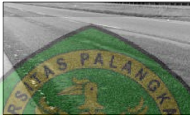
Gambar 2.18 Pelepasan Butir ( Raveling )
